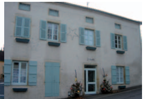
Bâtiment communal réhabilité en logements locatifs aidés, Melay (71) Maitrise d'ouvrage communale
