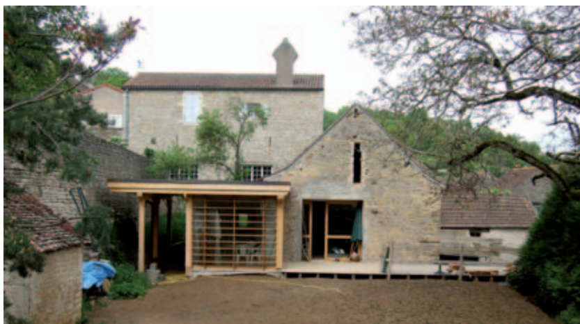
Réhabilitation d'une Grange en maison d'habitation (71), extension du volume principal en bois, Philippe Vieuxmaire architecte
