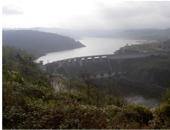
Figure 5 Barrage de Villerest
